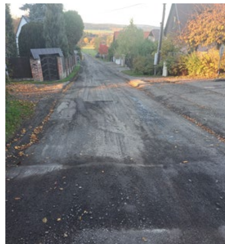
Vyfrézovaná silnice v Rymani
