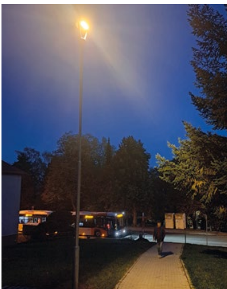
Nové osvětlení chodníku v ulici V Lipkách
