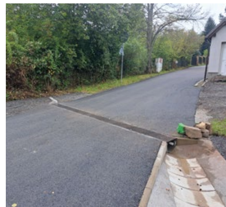
Komunikace Na Kvíkalce po opravě
