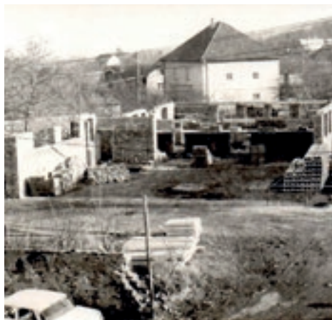
Stavba nové zbrojnice trvala 2 roky. Foto: archiv
