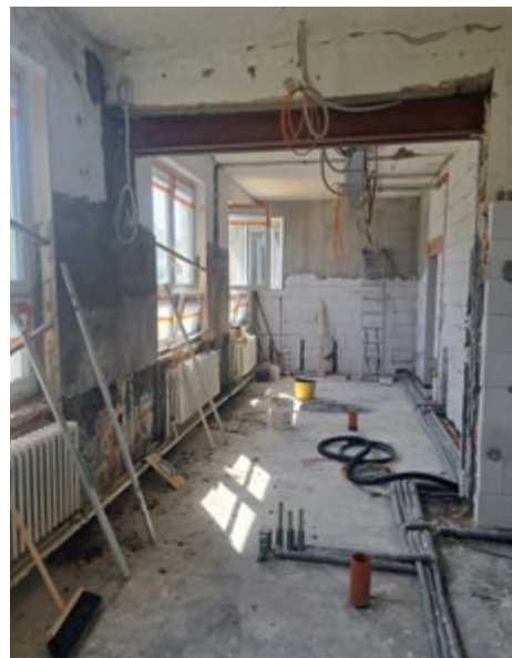
Prostor pásové myčky na bílé nádobí (stav rekonstrukce jídelny k 27. 8.)
