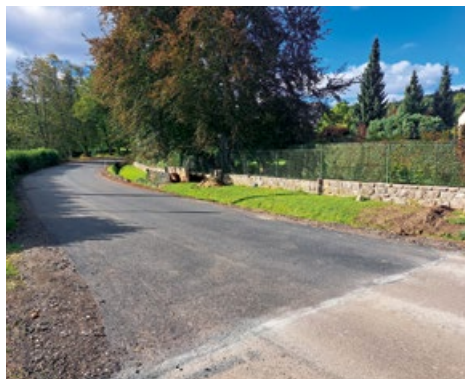
Nový asfaltový povrch silnice ve Stříbrné Lhotě
