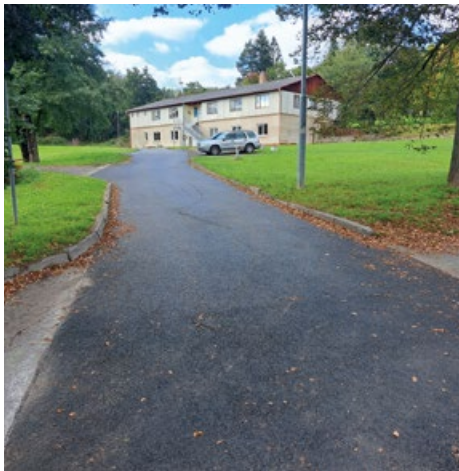
Nový asfaltový povrch silnice Na Oboře
