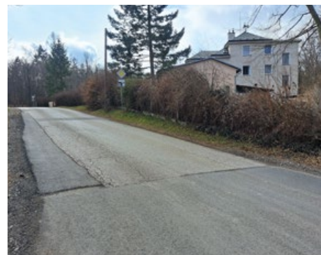
Oprava povrchu silnice začne v květnu z těchto míst
